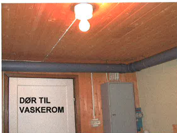
7. Rør med 90° bend, festet til tak med patentband.
